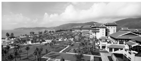
ザ・リッツ・カールトン三亚(海南島)
